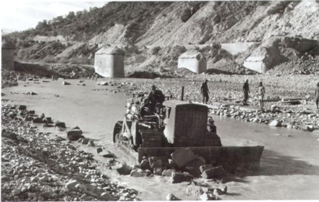
8 novembre 1943. Un bulldozer dell'8 a Divisione indiana sgombera le macerie del demolito ponte sul Trigno sotto Tufillo per preparare un guado temporaneo (per gentile concessione dell'Imperial War Museum – London).
